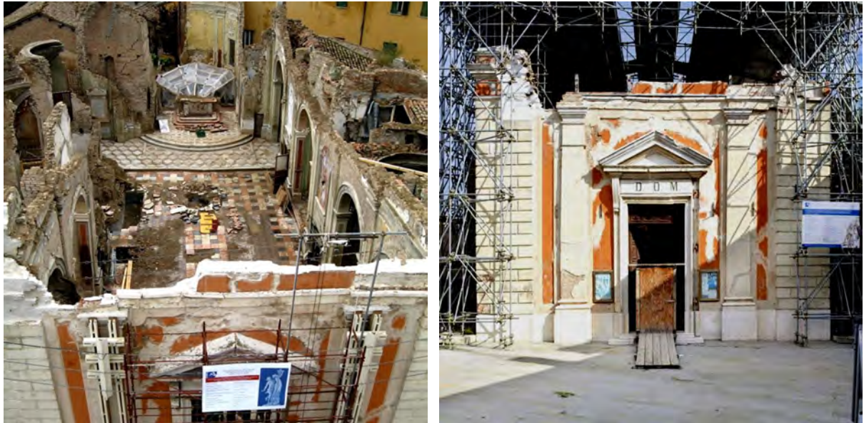
Fig. 28 - Terremoto dell'Emilia del maggio 2012, chiesa di San Felice sul Panaro: a sinistra la chiesa dopo la rimozione delle macerie; a destra, le rovine dotate di una copertura provvisoria (ATLANTE, Centro e Nord, pag. 644).
