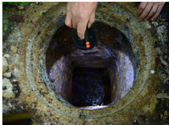
Figura 12. Punto "1" di captazione di vena di acqua nel ramo Trinità.
