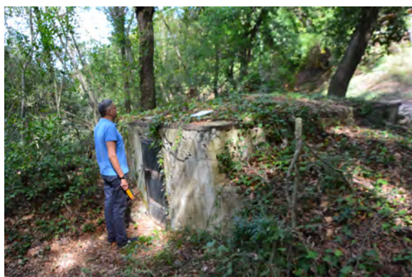
Figura 8. Vasca di raccolta dell'acqua che proviene dai due rami dell'acquedotto, corrispondente a "4 Purgatore" in C della mappa di Lulier (v. Fig. 3).
