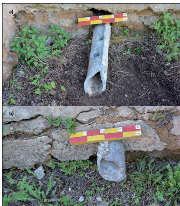
Figura 16 - I tubi di piombo con sezione ellissoidale a sinistra (a) e a destra (b) della base del contrafforte.
