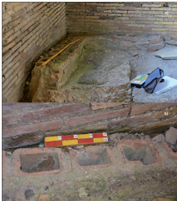
Figura 14 - Parte del pavimento del sistema ipocausto dell' apodyterium (22 in figura 12) che mostra in (a) i tubuli con forma geometrica parallelepipedica rettangolare costituiti da laterizio e in (b) un particolare di questi ultimi.
