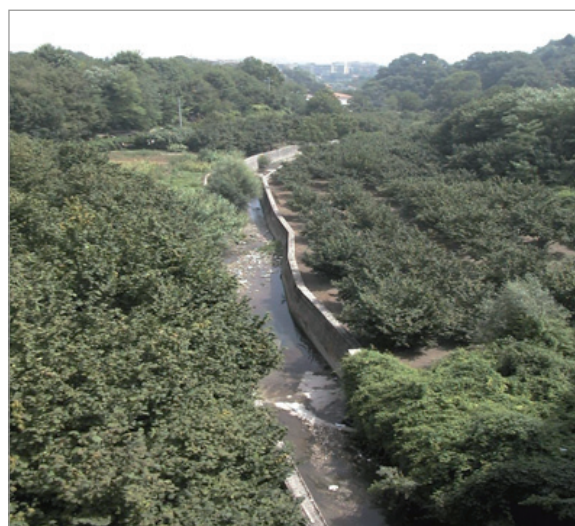
Tratto del torrente Fenestrelle interessato da scatolare in c.a.. Stretch of Fenestrelle river interested in c.a. box.
