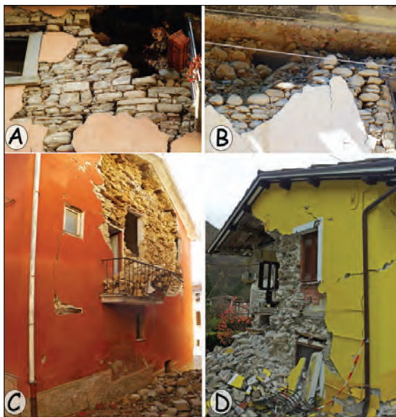
Fig. 3 - Muratura in pietra con scarsissimo legante. A-B, Retrosi e Sommati (Amatrice, RI), muratura a blocchi squadrate e/o in ciottoli di fiume in materiale arenaceo. C-D, Gualdo e Sasso (MC), muratura mista di pietre arrotondate e squadrate in arenaria e calcare.
