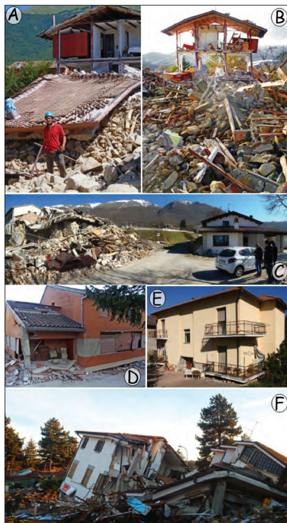
Fig. 5 - Differenti tipologie di danno. A, edificio in pietra (Petrana, Amatrice) crollato sotto il peso del pesante tetto in cemento armato. In secondo piano, porzione della stessa casa rinforzata da un telaio in acciaio (foto del 25 Agosto); B, stessa casa dopo il terremoto del 30 Ottobre, con il solo scheletro in acciaio ancora in piedi. C, confronto tra il comportamento di un edificio recente in muratura portante in Poroton® (destra) e una casa in pietra restaurata di recente con cordoli in C.A. e catene in acciaio (campagna di Norcia). Schiacciamento del piano soffice in un edificio in C.A. (D) ed in uno in muratura (E) a Norcia. F, crollo di edifici in C.A. ad Amatrice, entrambi apparentemente integri dopo il terremoto del 24 Agosto.
