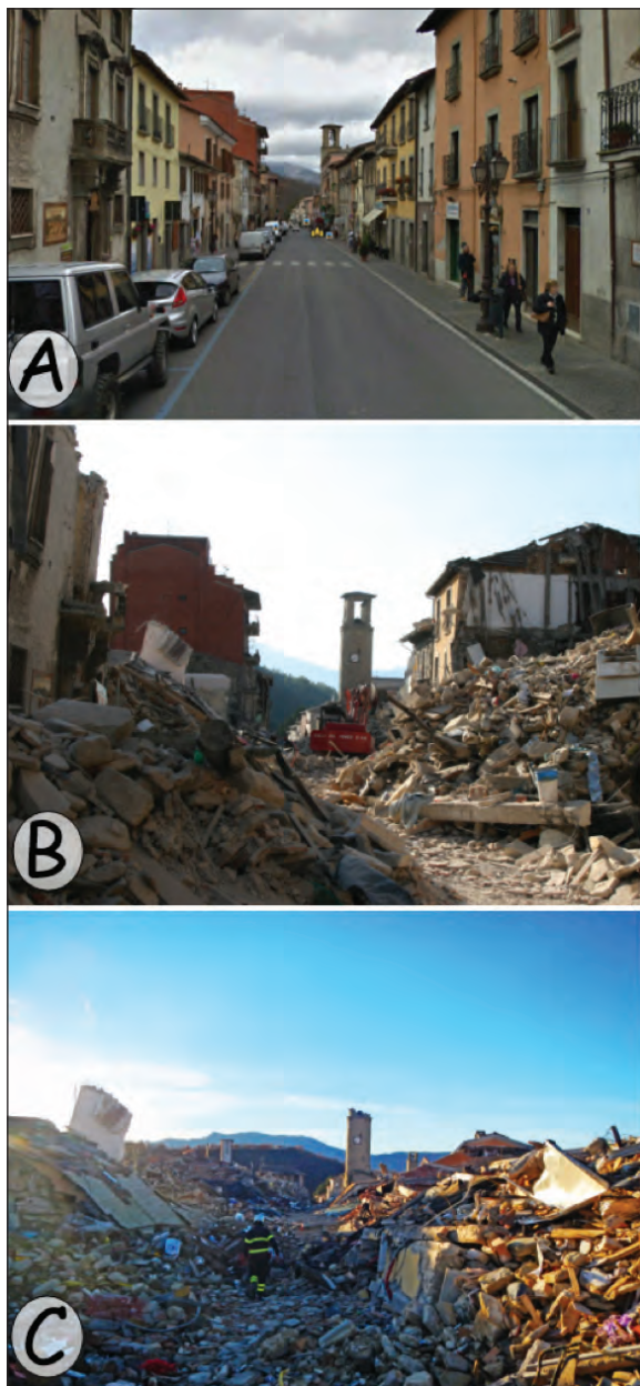
Fig. 6 - Distruzione progressiva del centro storico di Amatrice (veduta su Corso Umberto, guardando a ovest). A, prima di Agosto (immagine Google Street). B, dopo il 24 Agosto (Is X-XI MCS). C, dopo il 30 Ottobre (Is XI MCS). Si noti il crollo del condominio rosso in C.A., avvenuto con il terremoto del 26 Ottobre, a confronto con l'incredibile resistenza della torre civica medievale, ancora in piedi, a meno dell'altana, dopo mesi di scosse (comprese quelle del lontano terremoto del 1639, Mw 6.0).
