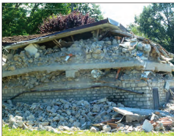
Fig. 4 - Crollo totale di un edificio in muratura con solai in C.A. (San Lorenzo e Flaviano, Amatrice).
