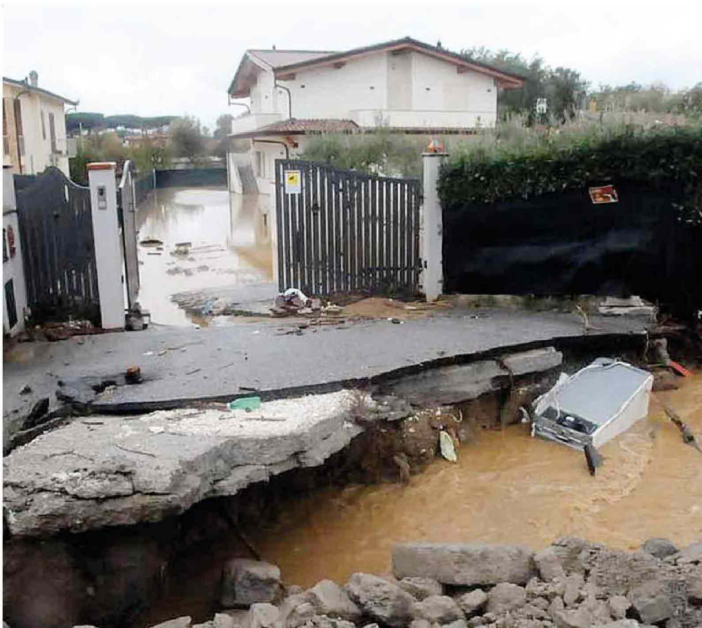
Il torrente Ricortola, nel territorio di Massa, esonda per il crollo dell'argine (foto Matelli)
