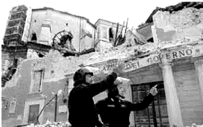
La sede della prefettura dell'Aquila crollata nel terremoto del 2009
