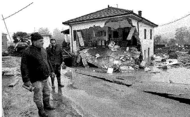
Il dopo alluvione in uno dei centri liguri maggiormente colpiti dal maltempo: Brugnato (La Spezia)
